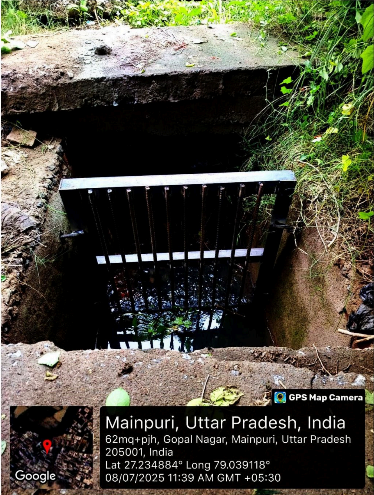
चांदेश्वर रोड पर स्थित भदौरिया ट्रैडर्स के पास नाले पर जाल लगाये जाने का कार्य
